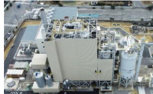
小名浜バイオマス発電所 運転員派遣
