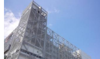
J&T環境株式会社 産廃処理施設修繕工事
